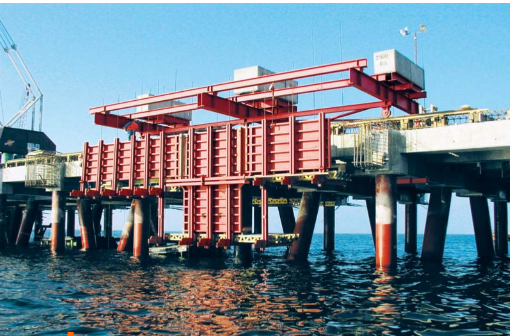
Foto 2. Carro moldaje viga perimetral (faldón).
