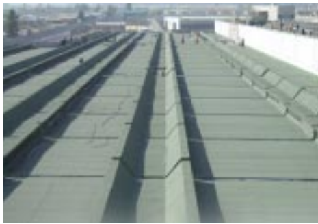
Membrana asfáltica aplicada en cubierta de talleres del Metro (Dynal).
