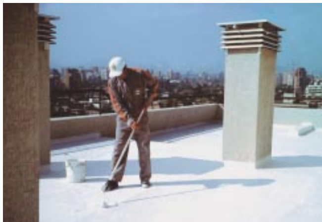
Aplicación de membrana in situ (Productos Cave).
