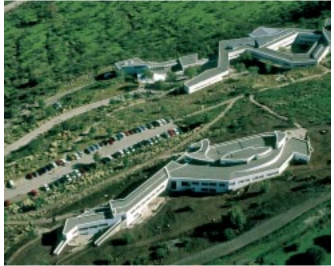
Membrana EPDM instalada en la Universidad Adolfo Ibáñez (Firestone, ICAM).
