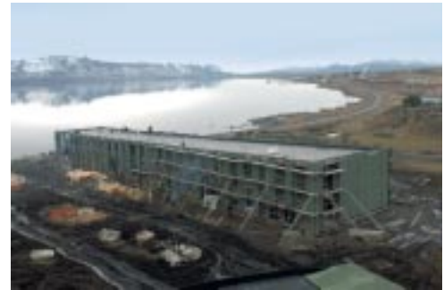
Aplicación de membrana en edificio en el sur de Chile. (Asfaltos Chilenos).
