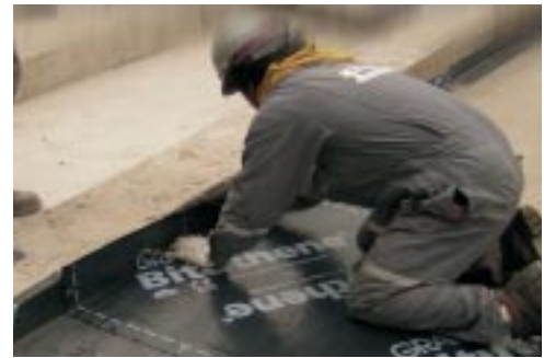
Instalación de membrana autoadhesiva (Grace Química).
