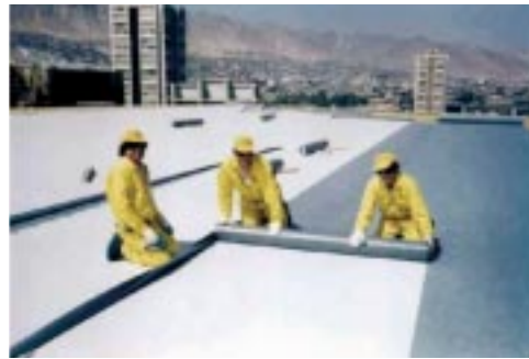
Instalación de membrana en cubierta de supermercado LIDER (Sika).
