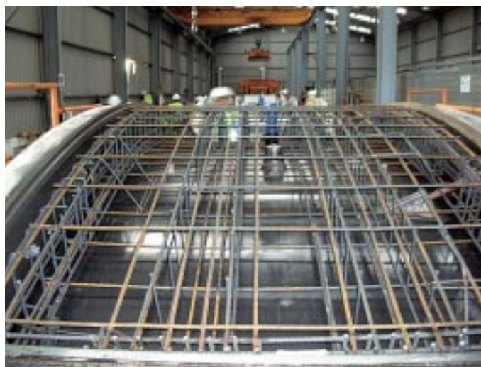
Molde de dovela antes de ir a la cámara de hormigonado.
