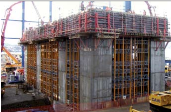
Proyecto Ampliación Termoeléctrica Bocamina II, Concepción
