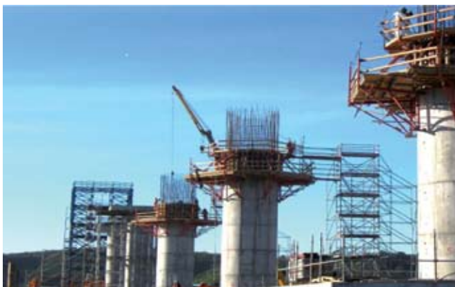
Proyecto Central Termoeléctrica Puerto Coronel, Coronel
