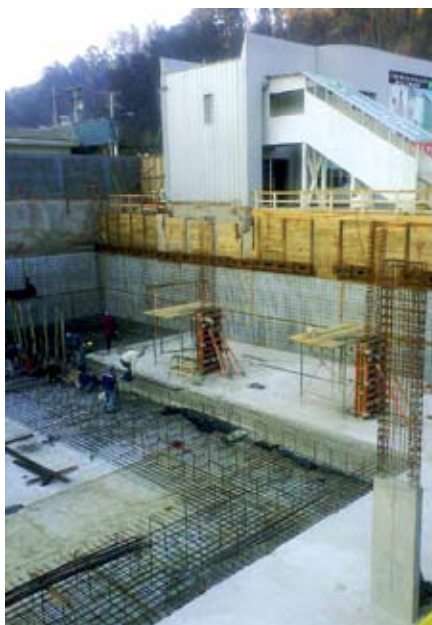
Impermeabilización de la losa de fundación.
