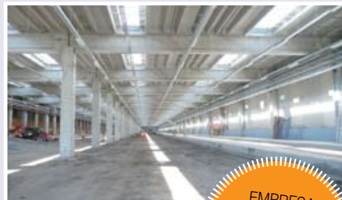
Talleres y Cocheras San Eugenio METRO Línea 5
