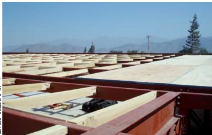
La cubierta fue construida como una estructura de acero y madera, y está suspendida a 1,40 m sobre el edificio para permitir la ventilación.
