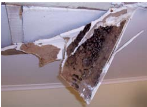
▲ Daños por putrefacción en el revestimiento interior de una vivienda a causa de la condensación intersticial.
