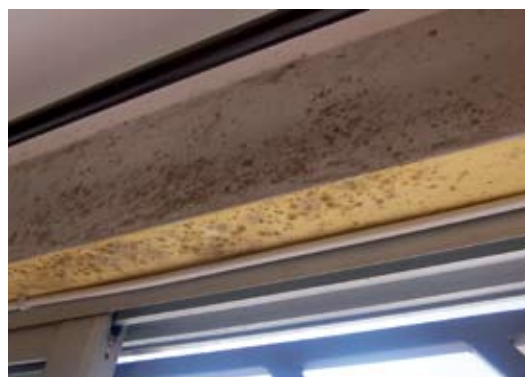
▲ Daños por putrefacción en el revestimiento interior de una vivienda a causa de la condensación intersticial.
