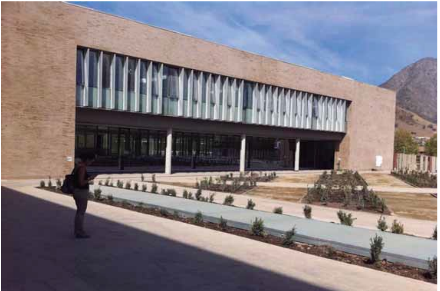
50.000 metros cúbicos de hormigón, 3.000 kilos de fierro y 160.000 metros cuadrados de moldaje permitieron levantar el nuevo Santiago College.
