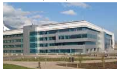
Sistema de aislamiento sísmico Hospital Militar, La Reina
