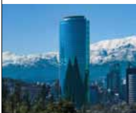
Sistema de disipación de energía Torre Titanium
