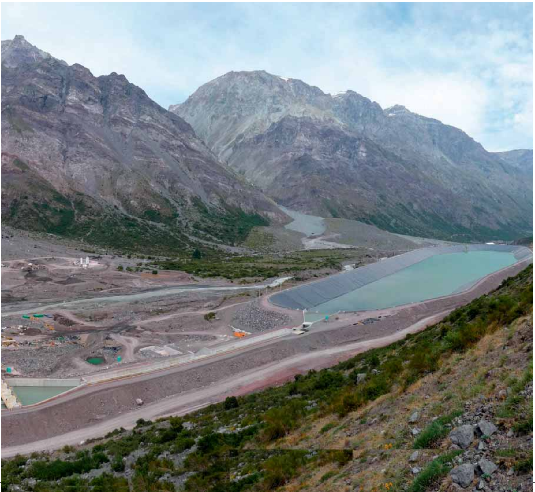
Central hidroeléctrica La Confluencia, 2010. Panorámica de la central hidroeléctrica La Confluencia. Se aprecian las montañas y el valle del río Tinguiririca, región de O'Higgins.
