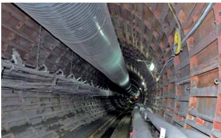
Dependiendo del tipo de roca hallada en el interior del túnel, se aplicaron dovelas metálicas (abajo) y pernos helicoidales en conjunto con malla Acma (en la foto).
